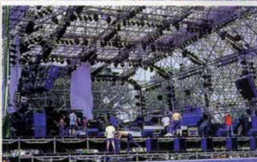
Due immagini del grande palco; si possono notare il maxi schermo di 50 mq., la disposizione delle luci sopra la scena e i due potenti sistemi side-fill sospesi.
