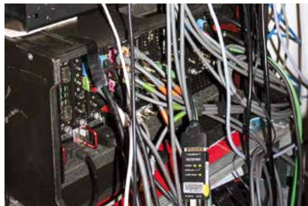
Per ricevere un segnale video da un'altra sala è necessario convertirlo per il trasporto su fibra utilizzando trasmettitori e ricevitori attivi. Nella foto un modello ampiamente diffuso dell'ungherese Lightware.
