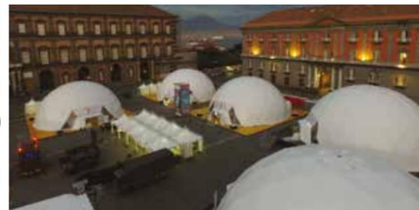
Tendostrutture Dome, strutture semisferiche da 346 mq l'una. Cupole autoportanti che hanno un raggio pari a 10.5 mt, composte da aste tubolari e giunti sferici in acciaio.
