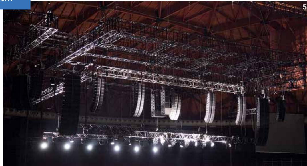
5\_ La configurazione degli impianti – i 5 array centrali di 12 KARA ognuno sono il sistema di "scena", mentre i due array agli estremi con 9 KARA ognuno sono le "estensioni". I due array lunghi di K2 rimangono spenti. Si nota anche il cluster dei sub KS28 appeso al centro.
