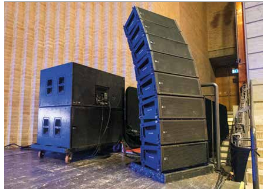
L'impianto PA composto da otto M'Elodie per lato più due sub in configurazione cardiode.
